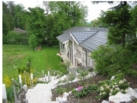
Leave garage building (eastward) Follow outdoor stairs downward Garagenbau nach Ost verlassen, Außentreppe nach unten gehen
